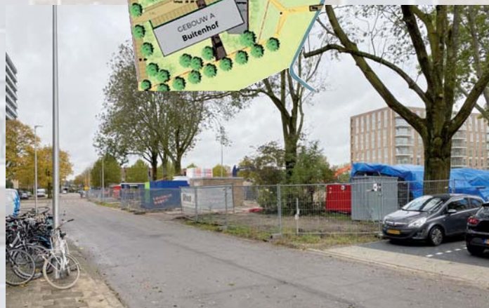
Bouwplaats gezien vanaf de Winklerlaan met rechts 'Forthof'
